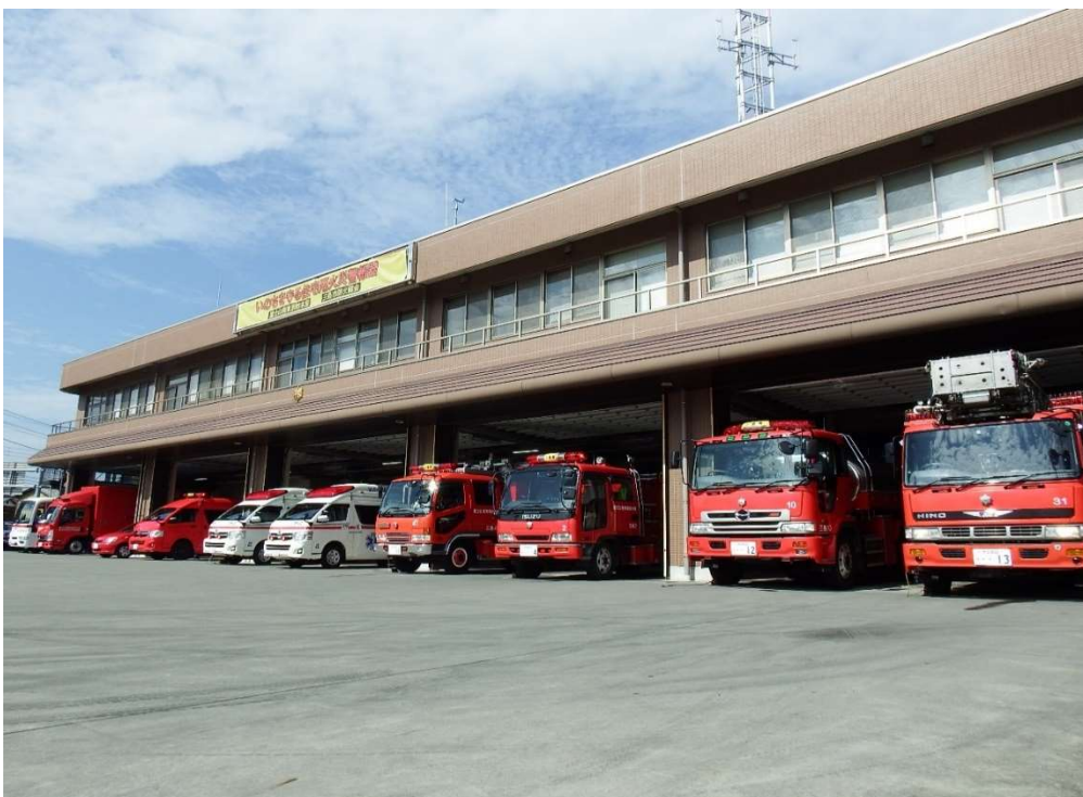
【写真】富士山南東消防本部三島消防庁舎車庫風景
